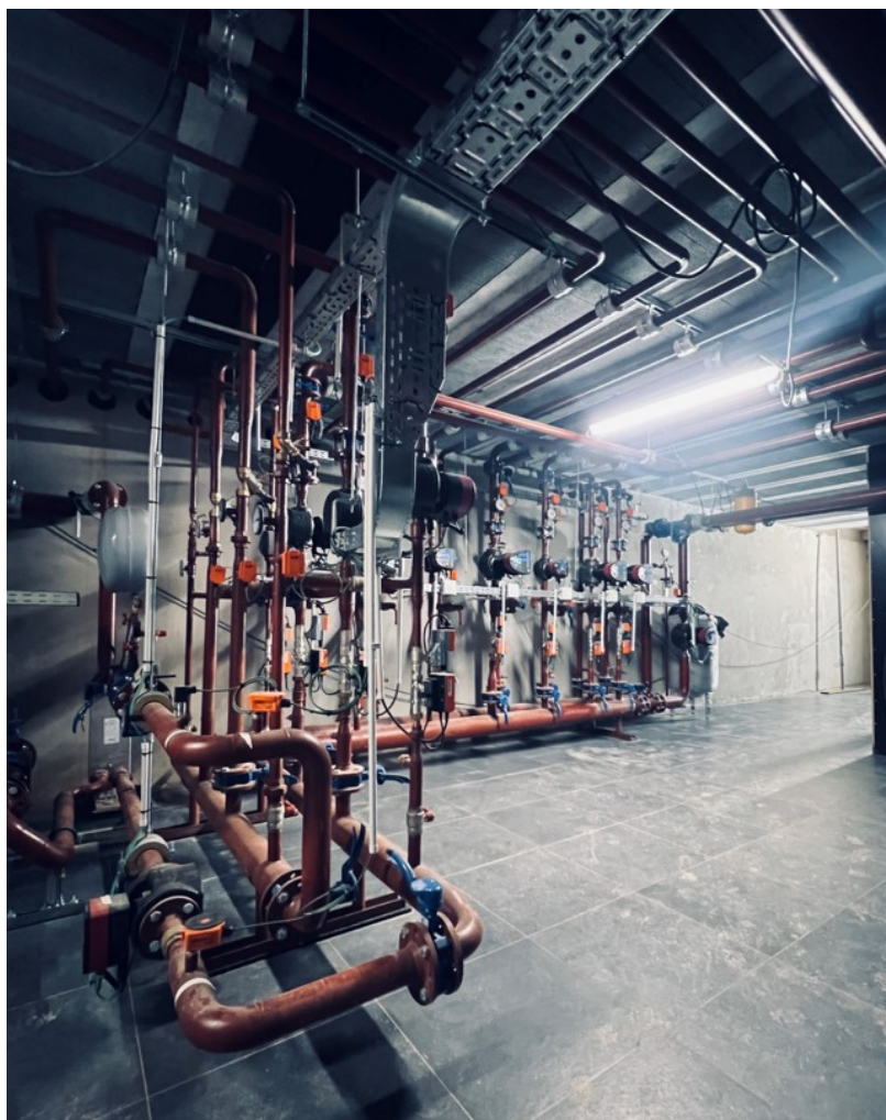
Lot HVAC en sanitair privéproject renovatie
