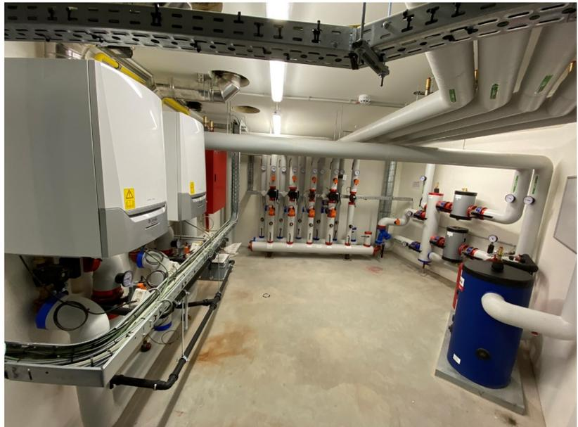
HVAC et SANITAIRE Rénovation d'un bâtiment classé Production de chaleur Chaudières à gaz Production de froid avec groupe froid monobloc Ventilateurs 2 Centrales de traitement d'air pour le refroidissement et le chauffage avec humidificateur et déshumidificateur à vapeur électrique.
