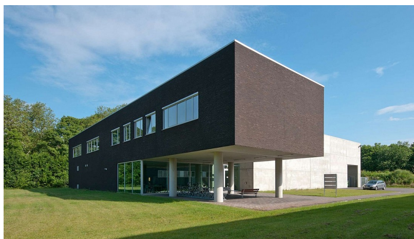
Construction centre de soudage
