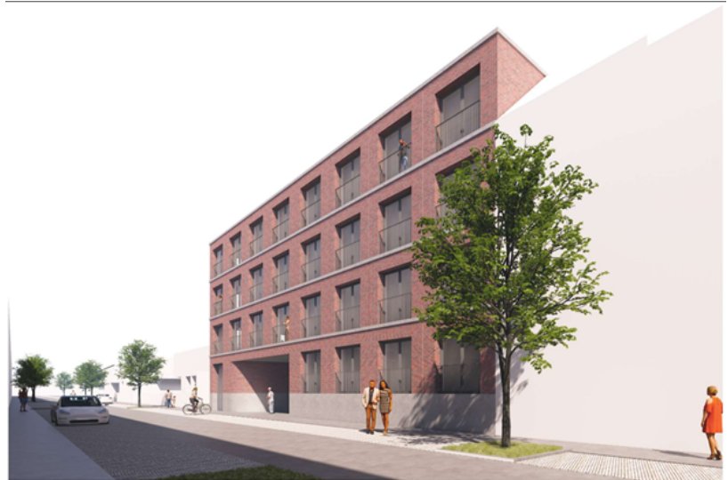
Zicht vanuit de zuidzijde van de Samberstraat
